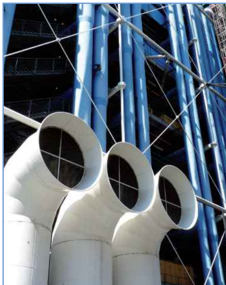
Détail de la structure du Centre Pompidou © Centre Pompidou / Philippe Migeat
