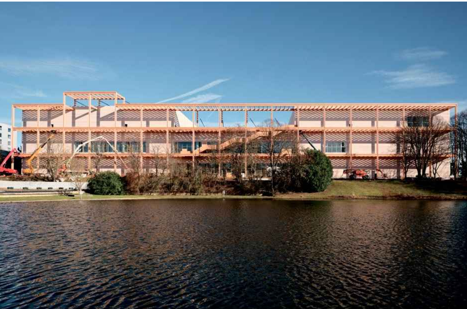
Le Centre Pompidou Francilien en cours de construction - Photo © Jean-Philippe Mesguen pour PCA-STREAM
